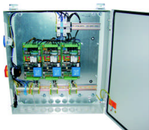
Schaltschrank mit Steuerelektronik für Läutemaschinen und Linearantrieb gleiche Steuerung
